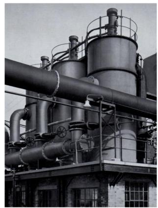
Photograph 29. Electrostatic detarrer.
